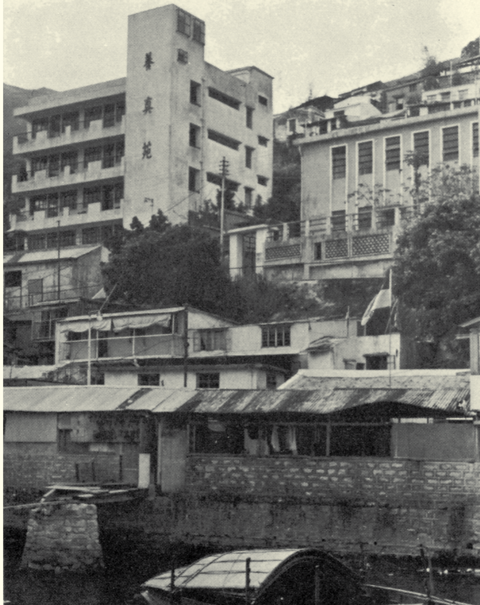
養真苑 Yang Chen House
